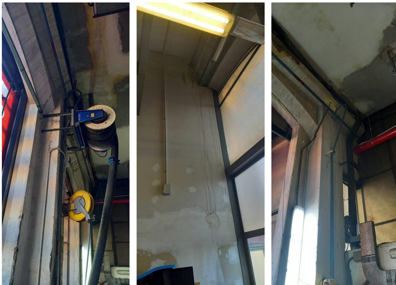
Alcune foto dei segni delle infiltrazione rilevate nel sopralluogo
