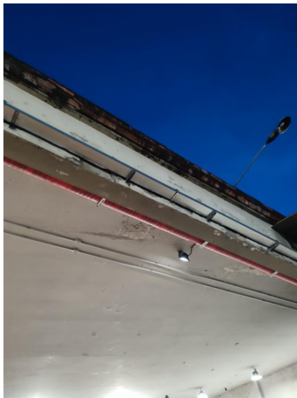
Facciate zona lavaggio con il dettaglio del cornicione con evidenti segni di distacco dell'intonaco
