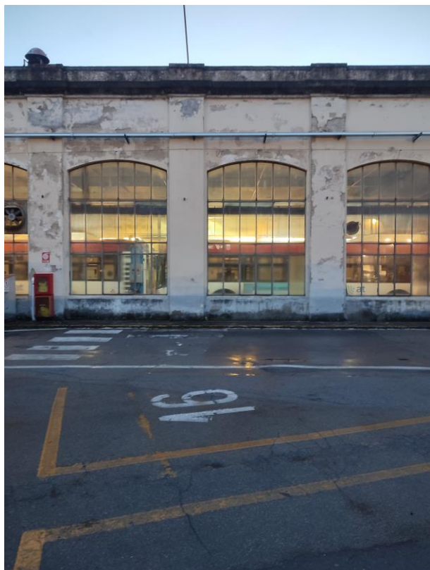
Facciate zona lavaggio con il dettaglio del cornicione con evidenti segni di distacco dell'intonaco
